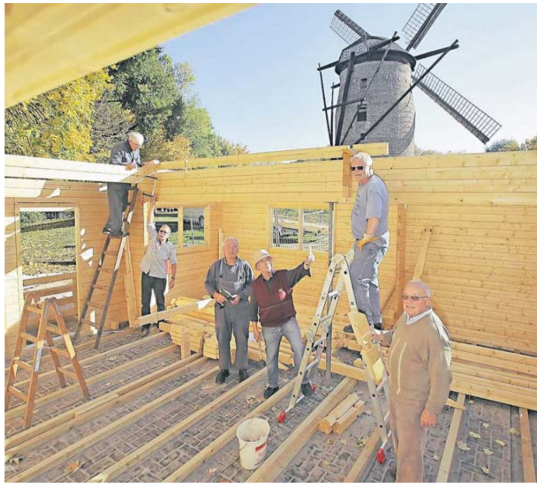
Acht Vereinsmitglieder bauen in diesen Tagen das Schulungshaus an der Geismühle.
