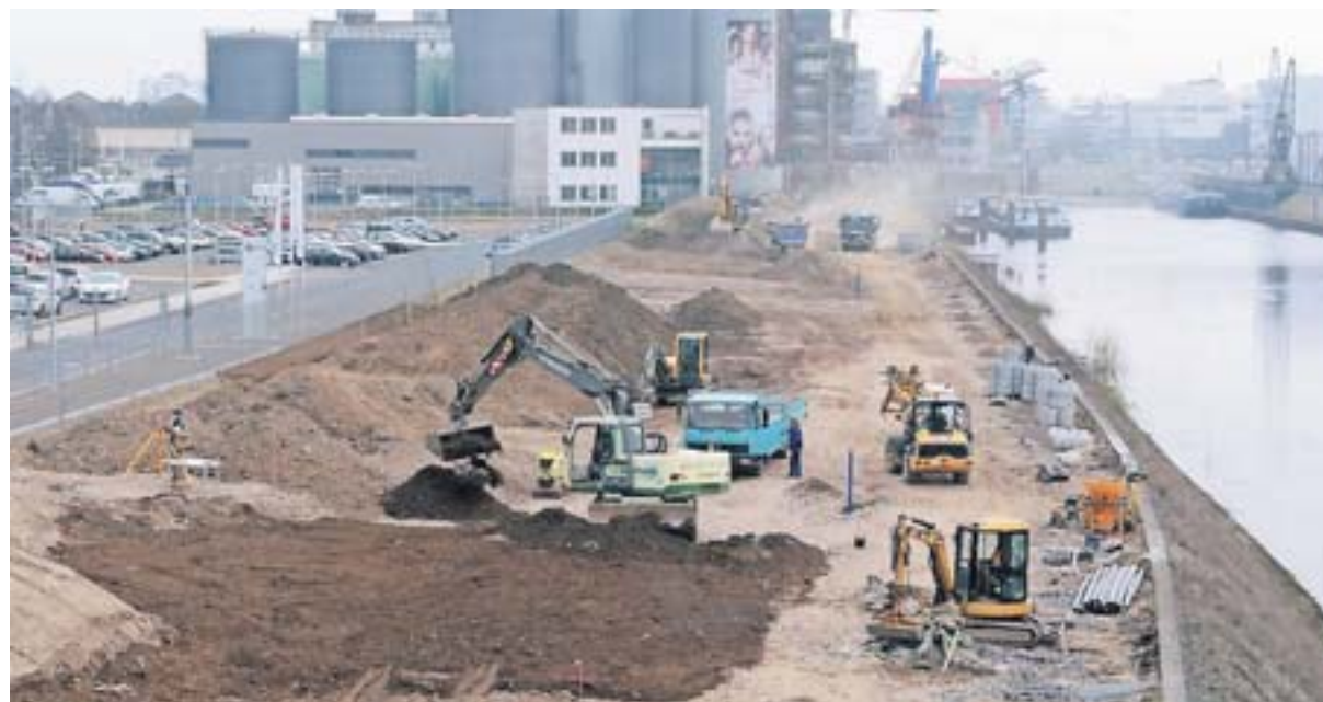
Die Erdarbeiten für den im Schnitt nur 30 Meter breiten, aber 850 Meter langen Uferpark auf der Hafemole I sind im vollen Gange. Ende Mai soll die neue innerstädtische Grünanlage mit Spielplätzen und Liegewiesen fertig sein. NGZ-FOTOS (4): WOI
